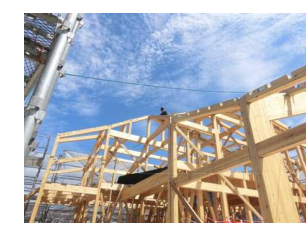
工事関係者により棟木が据え付けられました。
